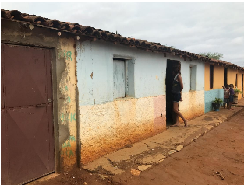
Figura 4-61 – Povoado de Felix Fonte: Projeta Engenharia (2017)
