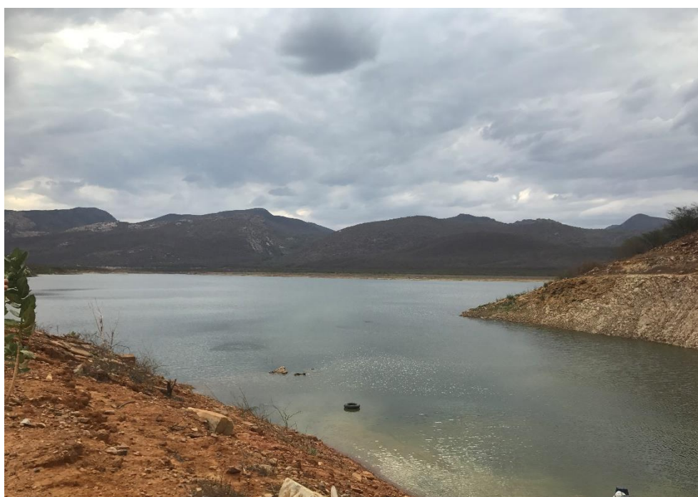
Figura 4-8 – Barragem de Mirorós
