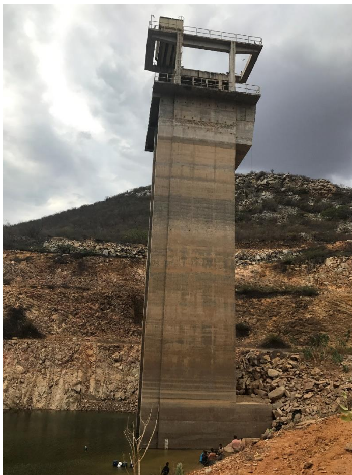
Figura 4-9 – Torre de tomada d'água – Mirorós
