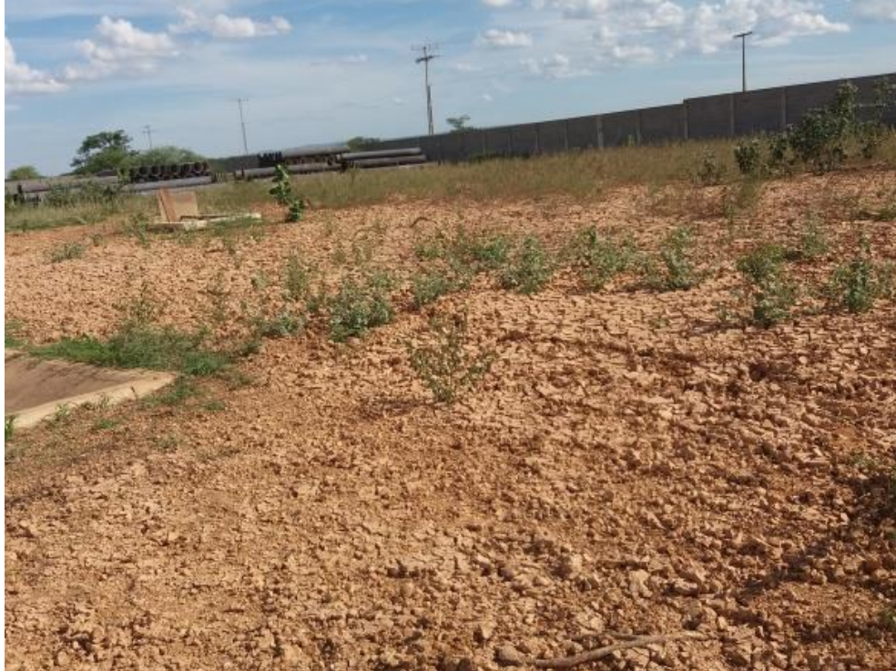
Figura 4-28 – Argila retirada do fundo da lagoa de descarga dos decantadores-ETA Rio Verde
