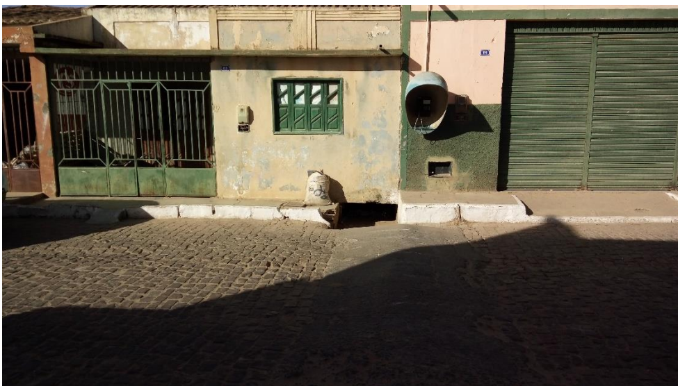
Figura 4-166 – Boca de lobo – Avenida Irecê - Soares
