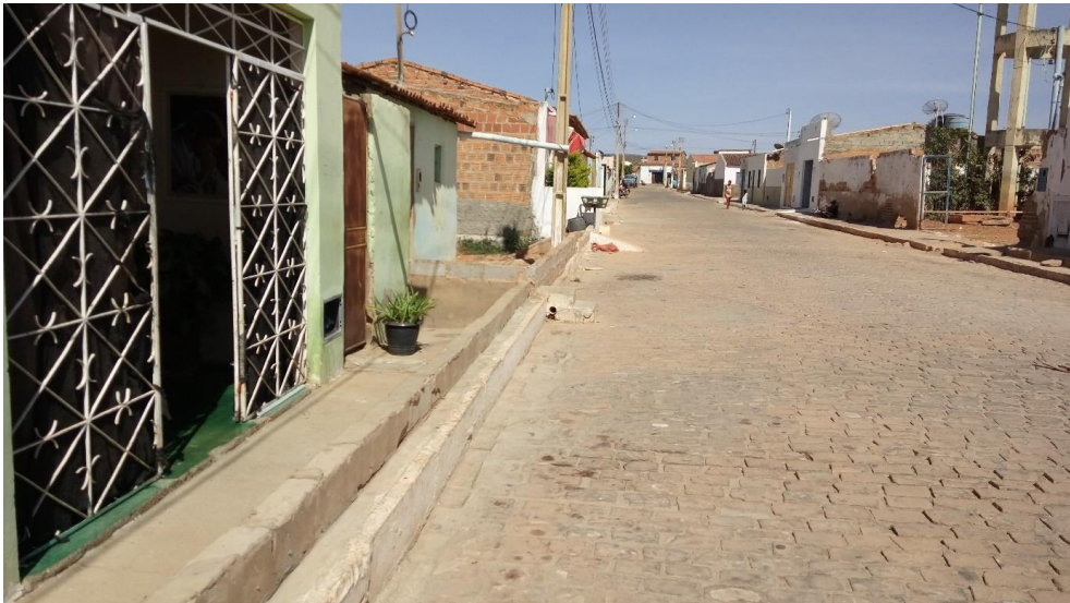
Figura 4-169 – Sarjeta - Ruas das Neves, Bairro Nova América - Sede Fonte: Projeta Engenharia (2017)
