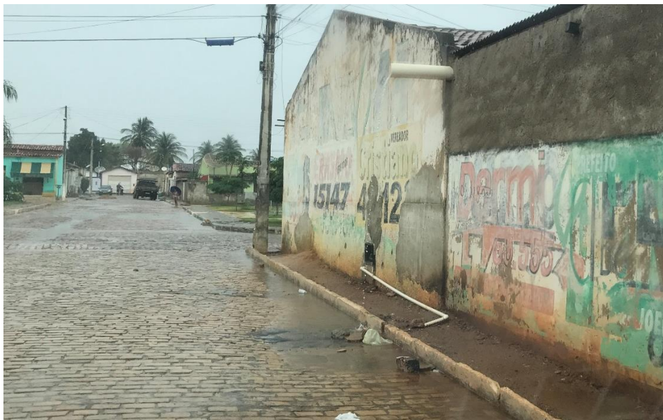
Figura 4-84 – Lançamento de esgoto em via pública – América Dourada Fonte: Projeta Engenharia (2017)
