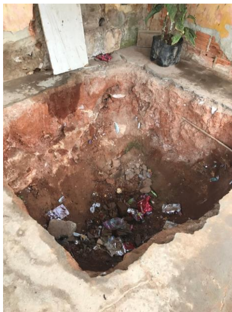
Figura 4-86– Construção de fossa negra – Nova América
