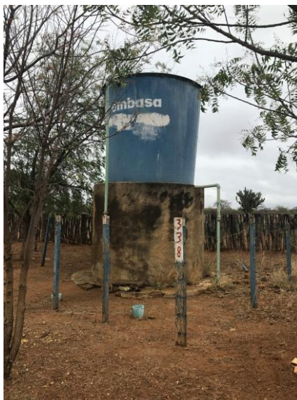
Figura 4-48 – Reservatório de água potável (Embasa) – Tanque
