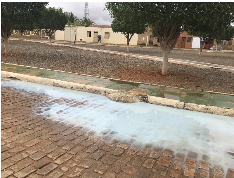
Figura 4-87 – Lançamento de esgoto na via pública – Soares
