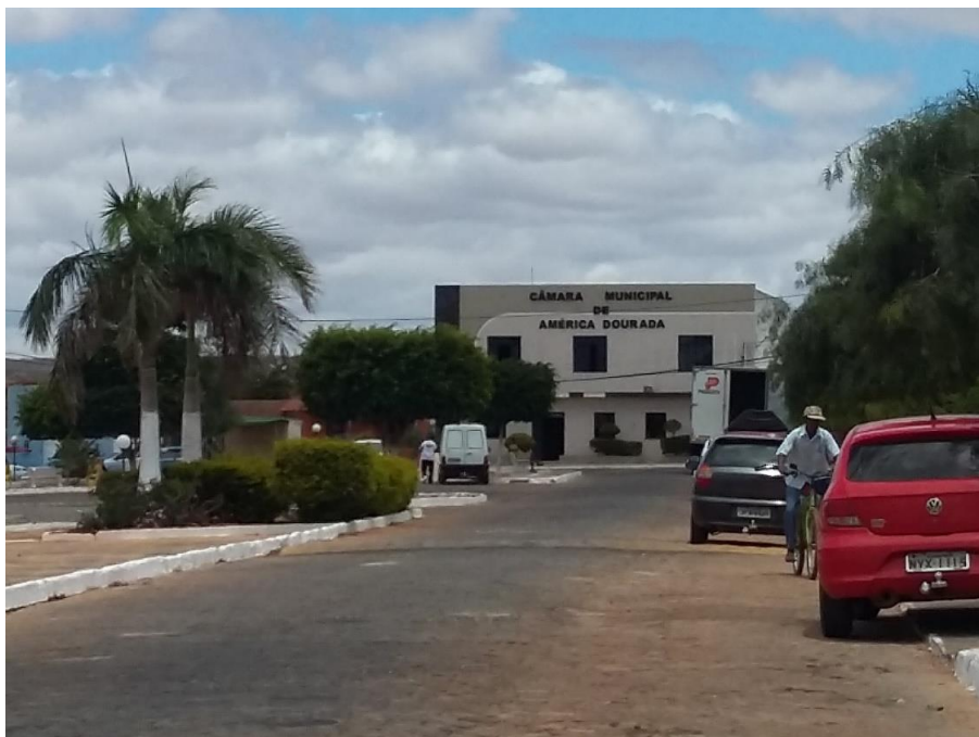
Figura 4-171 – Ausência de dispositivos de microdrenagem – Avenida principal da Sede
