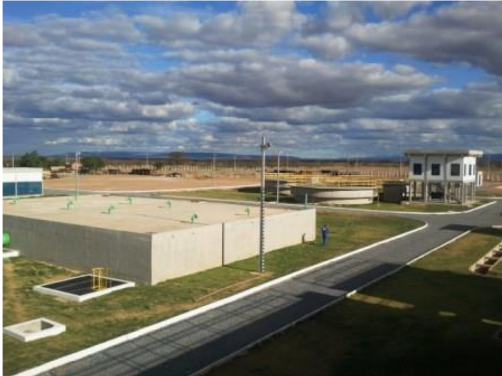
Figura 4-15 – Estação Tratamento de Água Bruta-ETA
