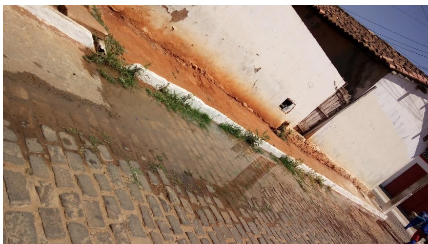
Figura 4-191 – Ponto S/N – Rua Aurora - Sede Fonte: Projeta Engenharia (2017)
