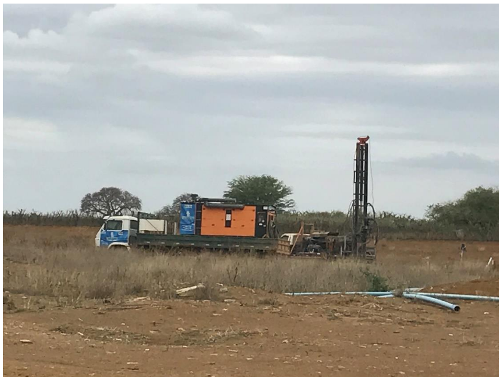
Figura 4-43 – Perfuratriz de poços artesianos
