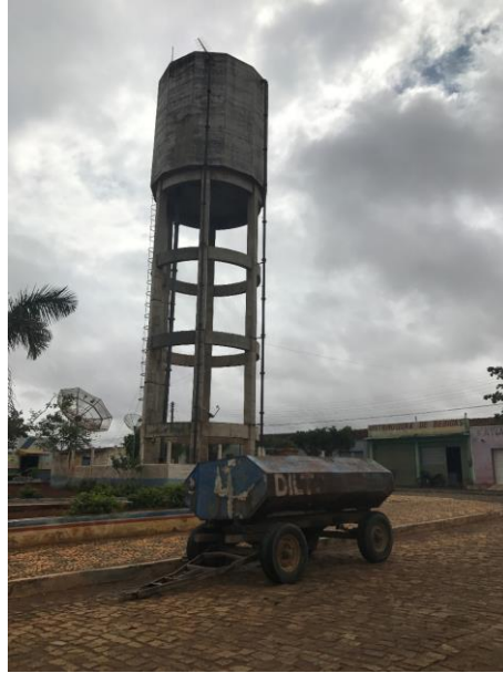
Figura 4-56 – Reservatório de água tratada (Embasa) – Soares
