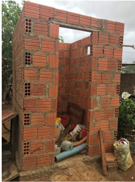
Figura 4-90 – Construção banheiro Projeto FUNASA – Mulungu Fonte: Projeta Engenharia (2017)
