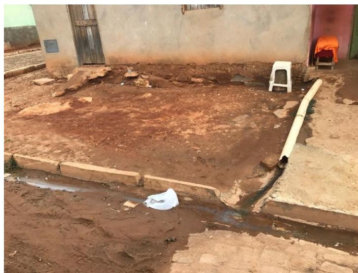
Figura 4-85 – Lançamento de esgoto na via pública – Sede América Dourada Fonte: Projeta Engenharia (2017)
