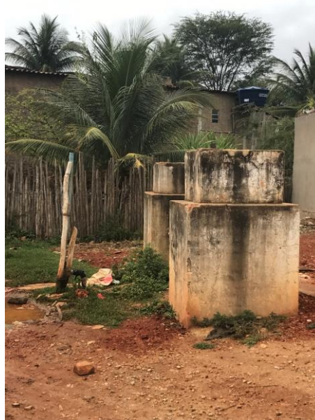
Figura 4-52 – Poço artesiano – Prevenido
