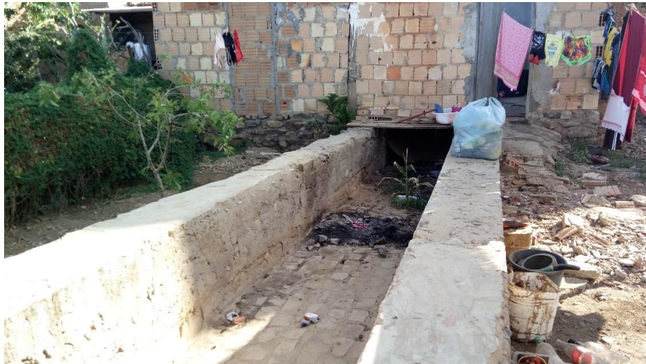
Figura 4-164 – Galeria para captação de água pluvial na Rua da Lagoa I - Soares
