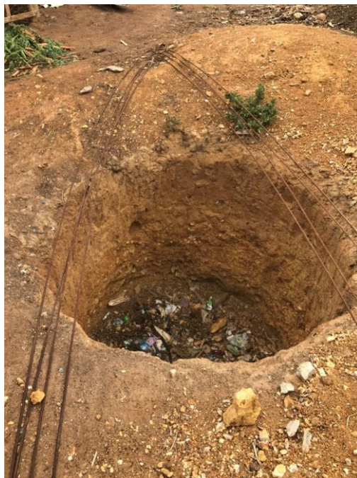
Figura 4-91 – Construção da fossa para banheiro Projeto FUNASA – Mulungu Fonte: Projeta Engenharia (2017)
