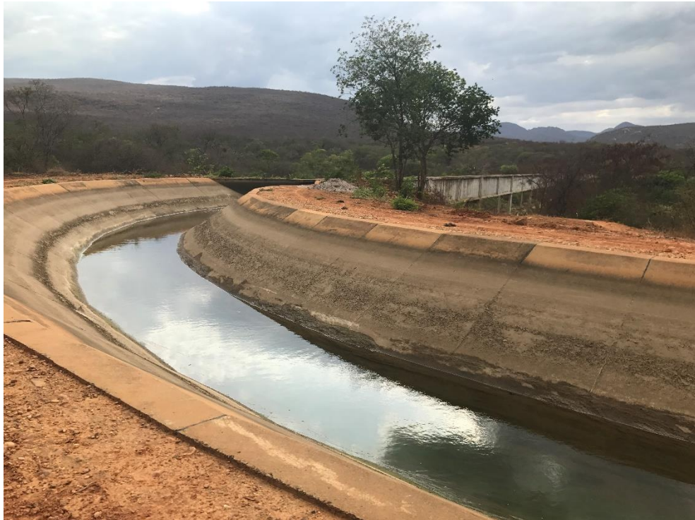
Figura 4-10 – Canal de tomada d'água
