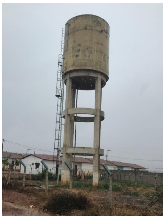
Figura 4-41 – Reservatório de água tratada (Embasa) – Nova América
