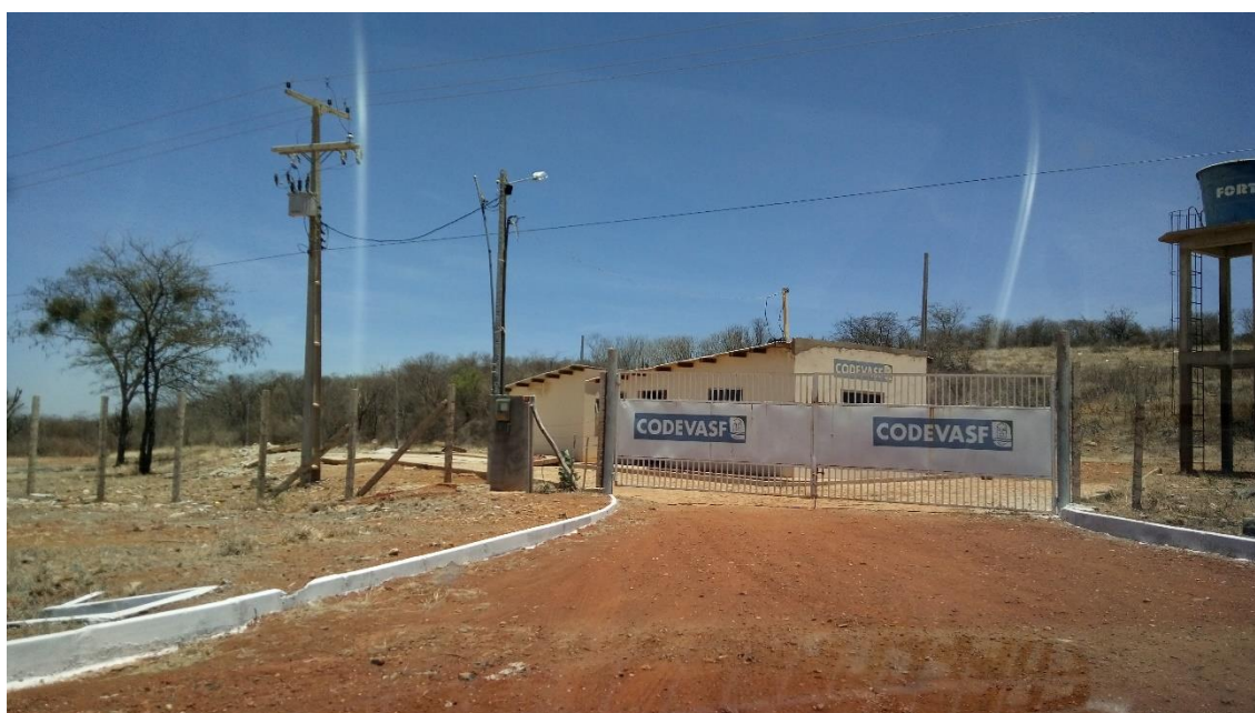
Figura 4-154 – Entrada principal do aterro sanitário no município de Irecê/BA
