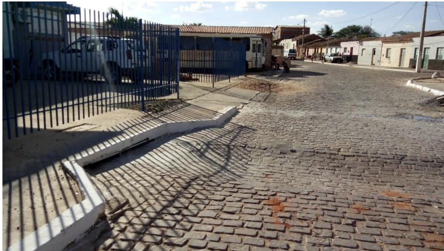
Figura 4-167 – Boca de lobo – Rua da Lagoa I - Soares Fonte: Projeta Engenharia (2017)
