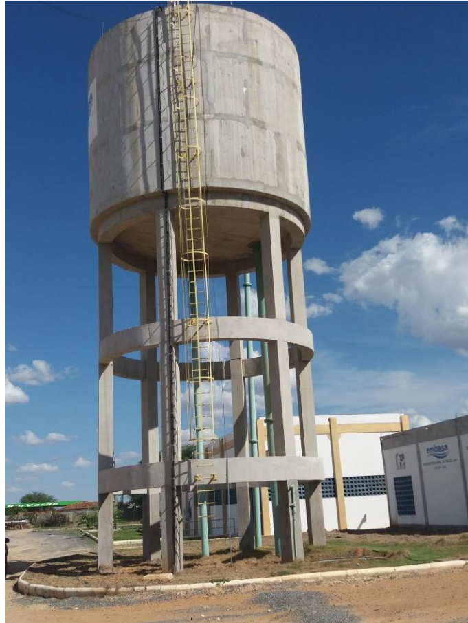
Figura 4-29 – Reservatório de uso geral - ETA Rio Verde
