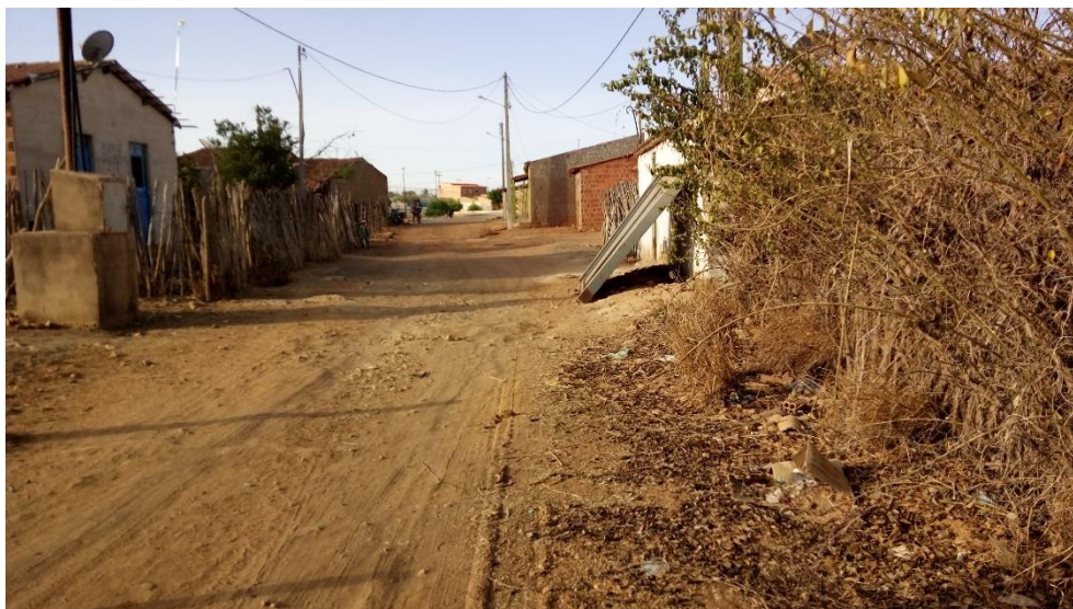
Figura 4-158 – Via não pavimentada próxima à via pavimentada (Rua da Matriz) – Distrito de Soares
