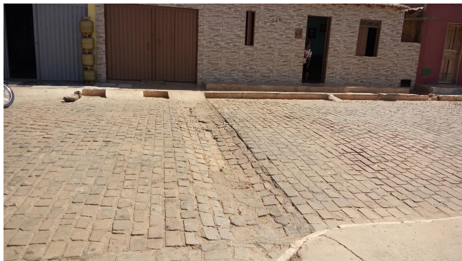
Figura 4-156 - Tipo de pavimentação no município de América Dourada: Calçamento poliédrico
