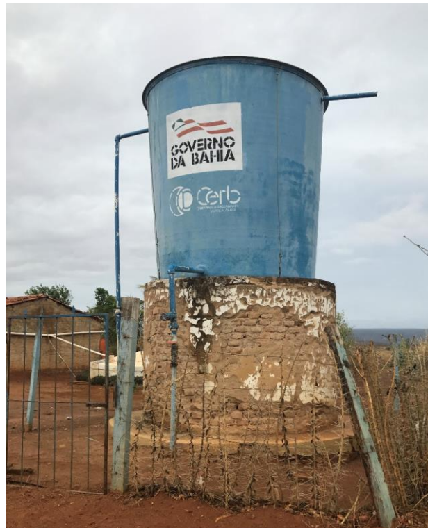
Figura 4-63 – Reservatório de água salobra – Felix Fonte: Projeta Engenharia (2017)
