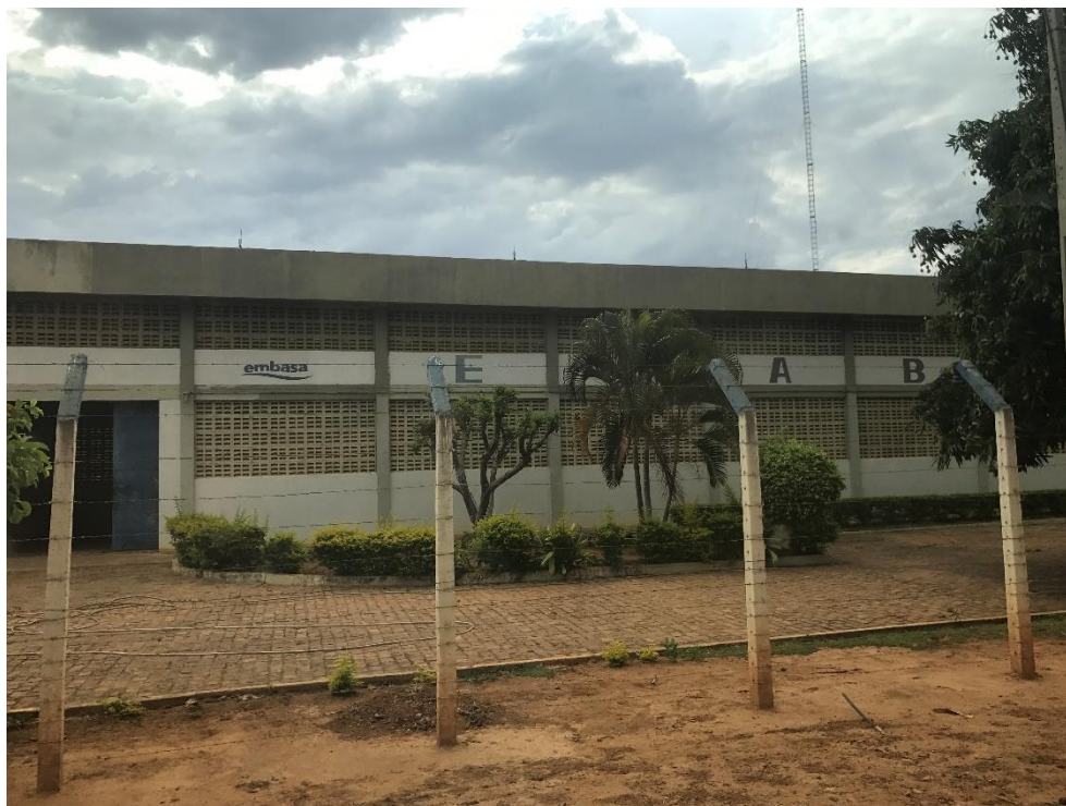
Figura 4-14 – Estação Elevatória de Água Bruta – EEAB1
