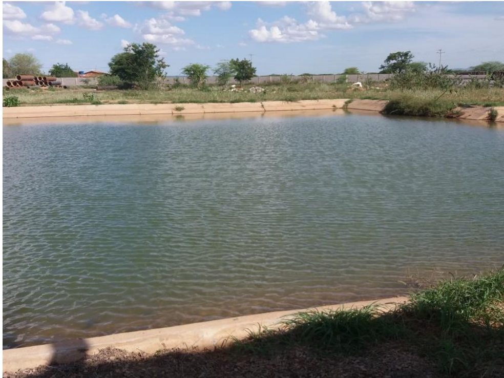
Figura 4-27 – Lagoa de descarga dos decantadores da ETA Rio Verde
