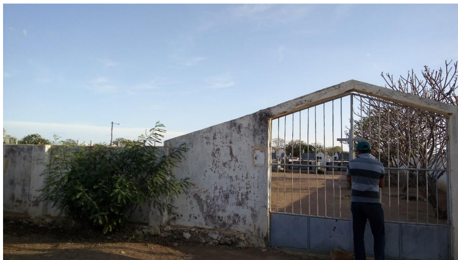
Figura 4-132 – Entrada do cemitério I do Distrito de Soares Fonte: Projeta Engenharia (2017)
