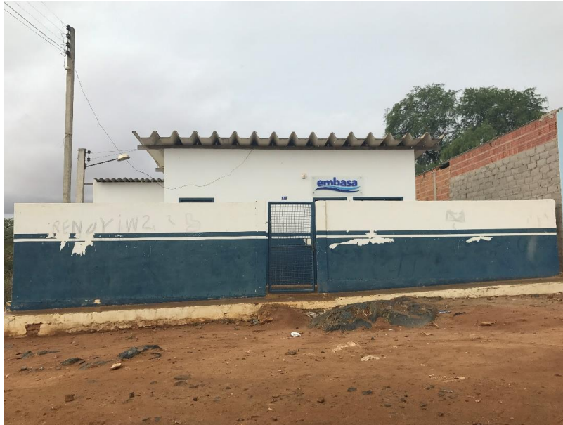
Figura 4-58 – Casa de mistura cloração de água de poço –Soares
