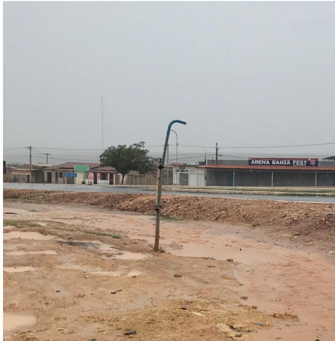
Figura 4-44 – Poço artesiano água salobra – Nova América
