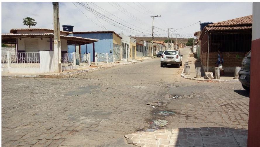
Figura 4-180 – Ponto 2 – Avenida Nestor Borges - Sede Fonte: Projeta Engenharia (2017)
