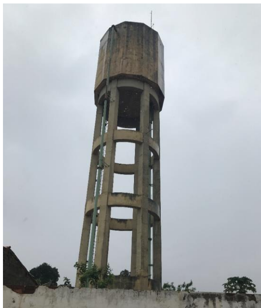
Figura 4-45 – Reservatório de água tratada (Embasa) – Nova América
