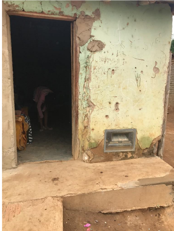
Figura 4-88 – Residência com rede de abastecimento (Embasa) hidrometrada – Soares Fonte: Projeta Engenharia (2017)
