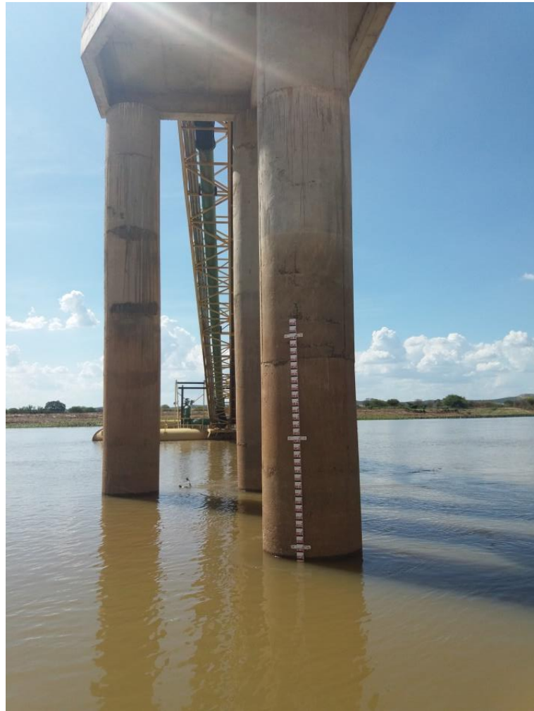
Figura 4-21 – Régua de medição do nível do Rio São Francisco.
