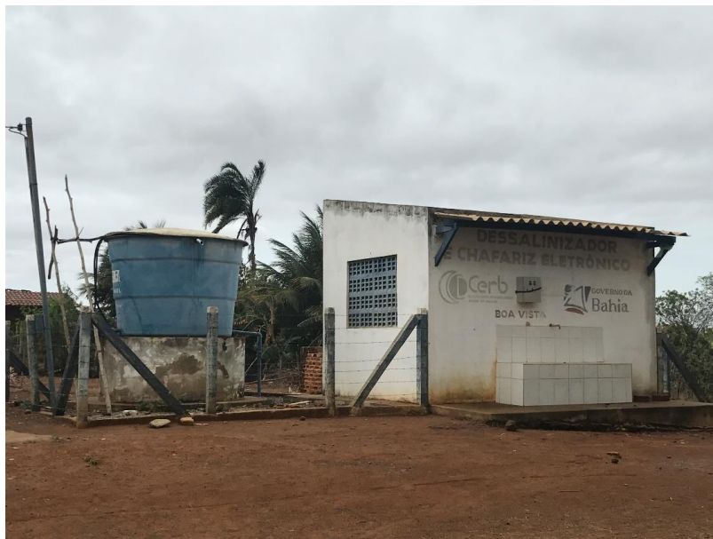
Figura 4-67 – Dessalinizador do povoado de Boa Vista Localização S: 11°24'12,0'' W: 41°25'56,8'' Fonte: Projeta Engenharia (2017)
