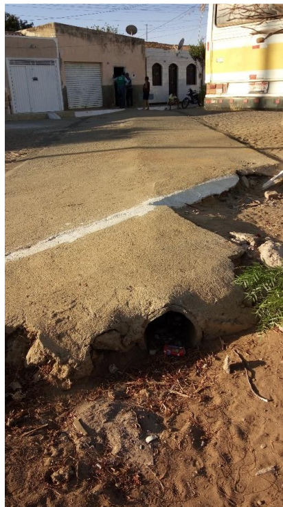
Figura 4-165 – Bueiro - Rua da Matriz -Soares
