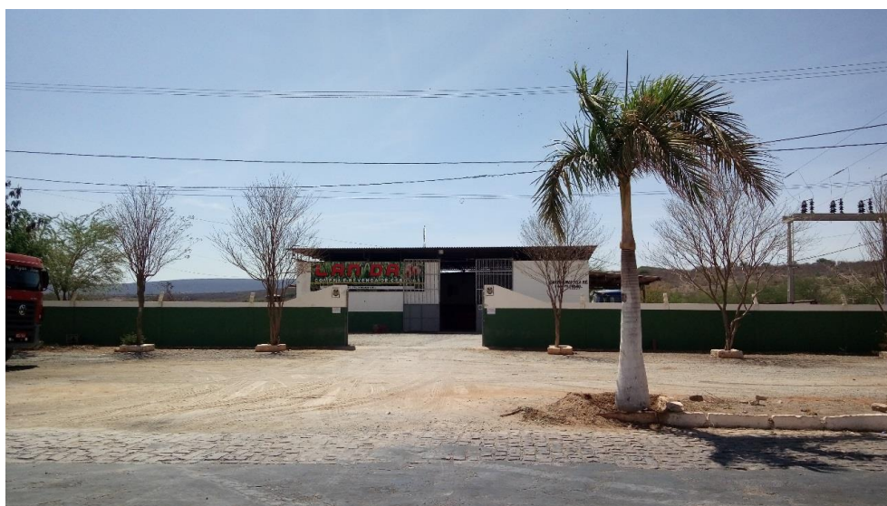
Figura 4-136 – Grande gerador de resíduos sólidos na sede do município de América Dourada
