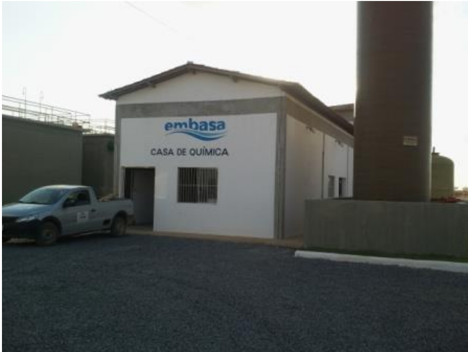
Figura 4-16 – Casa de química da ETA- Ibititá
