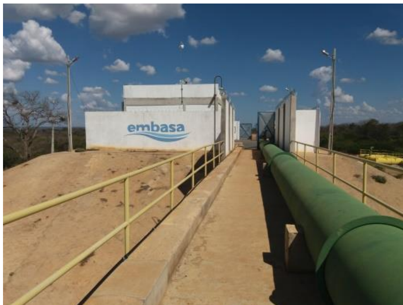
Figura 4-20– Portões de entrada do local de captação e adutora de água bruta.
