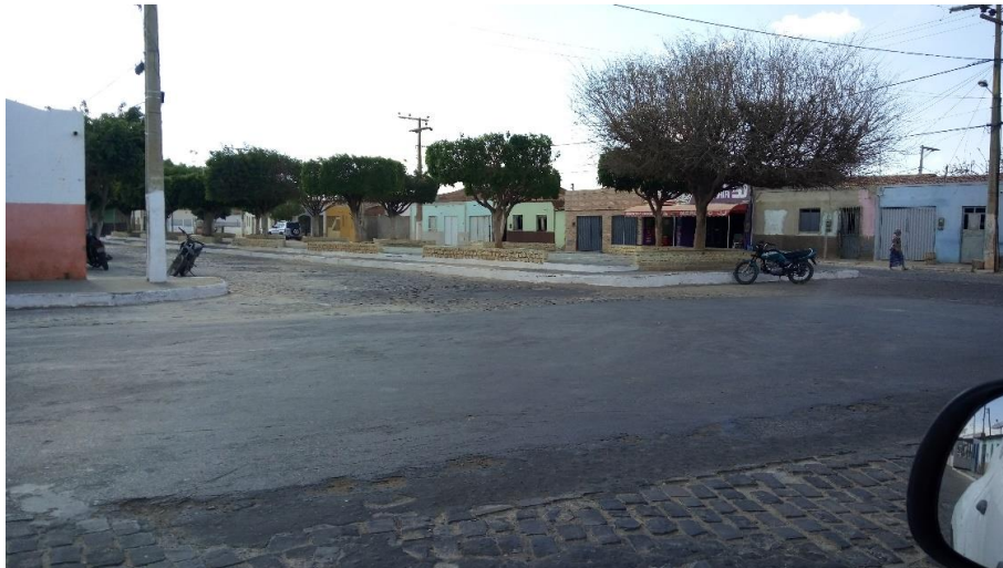
Figura 4-174 – Ausência de dispositivos de microdrenagem - Praça Soares do Meio, em Soares
